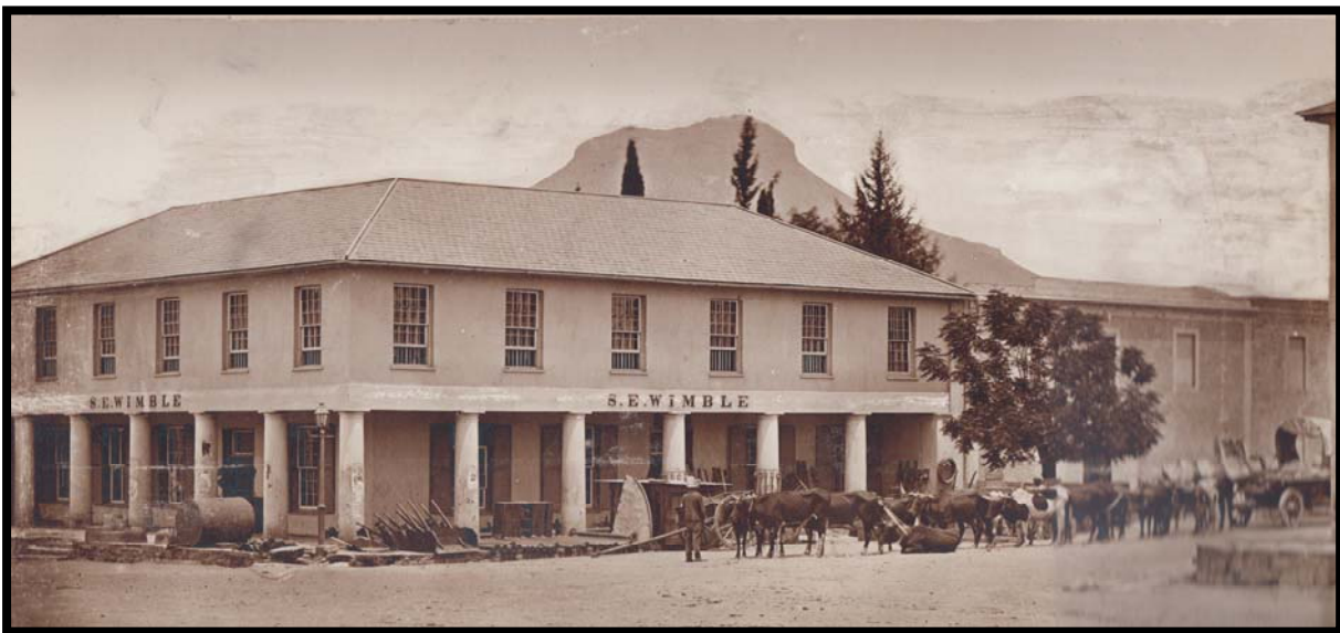
Figuur 6.6: Wimble winkelgebou op die hoek van Caledonstraat en Markplein (Foto: c1885)
