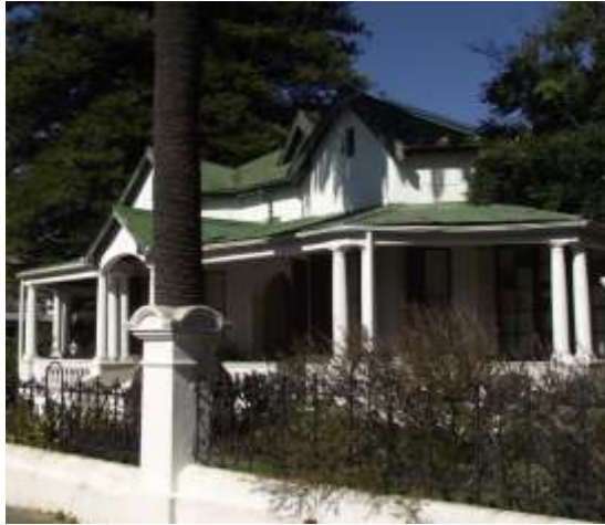
Figuur 5-51: Komplekse dakstruktuur, Nantesstraat, Paarl (Foto: AvZ 2013)
