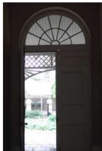
Figuur 5-71: Voordeur met agt panele, Wolmunster, Rosebank, Kaapstad (Foto: AvZ 2011)
