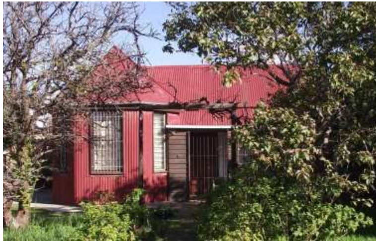
Figuur 5-116: Sinkhuis met erkervenster, Surreystraat 47, Goodwood (Foto: AvZ 2013)
