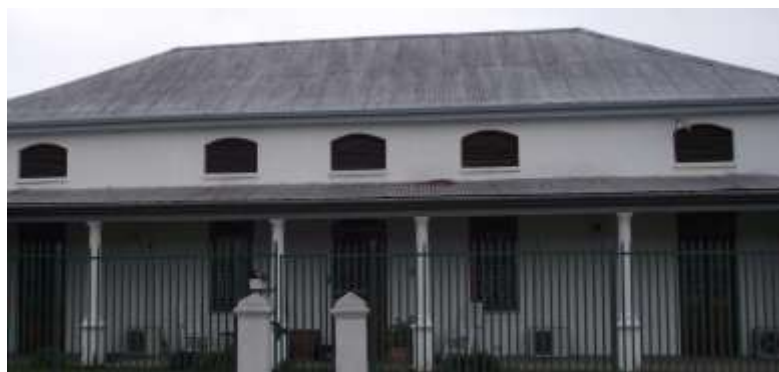
Figuur 5-111: Solderopeninge met hout ventilasieroosters, Hoofstraat, Paarl (Foto: AvZ 2013)
