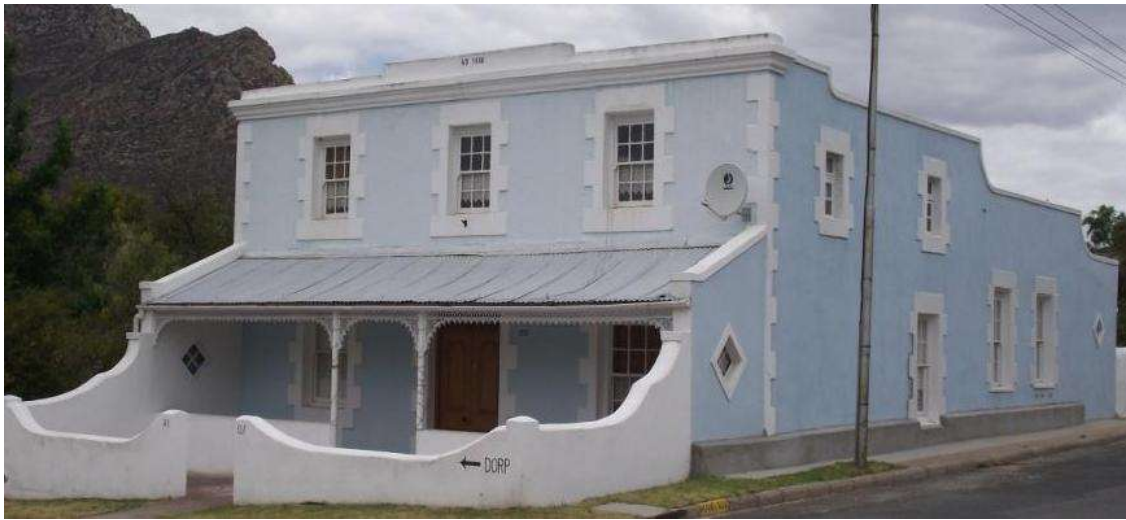
Figuur 5-45: Strukturele polichromie, Meulstraat, Montagu (Foto: AvZ 2012)
