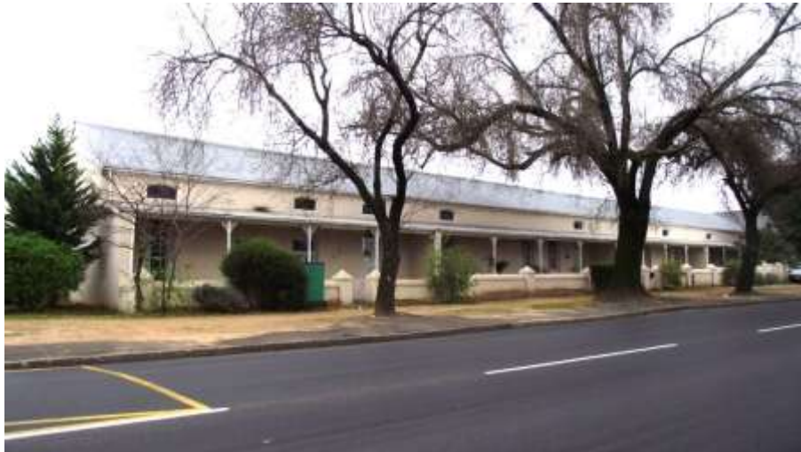
Figuur 5-9: Ry van vier skakelhuse, Hoofstraat, Noorder-Paarl (Foto:AvZ 2013)
