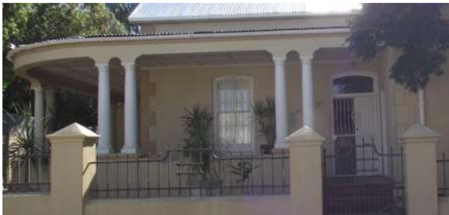
Figuur 5-119: Huis met beton stoeppilare, Du Toitstraat, Paarl (Foto: AvZ 2013)
