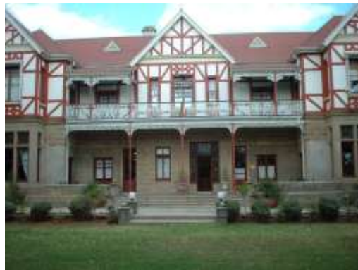
Figuur 5-17: Voorbeeld van vakwerk op Foster's Folly, Oudtshoorn (Foto: AvZ 2005)
