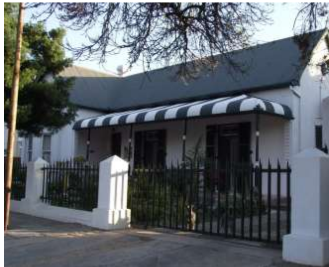
Figuur 5-97: Konvekse bullnose -sinkplaat, Bourkestraat, Graaff-Reinet (Foto: AvZ 2010)
