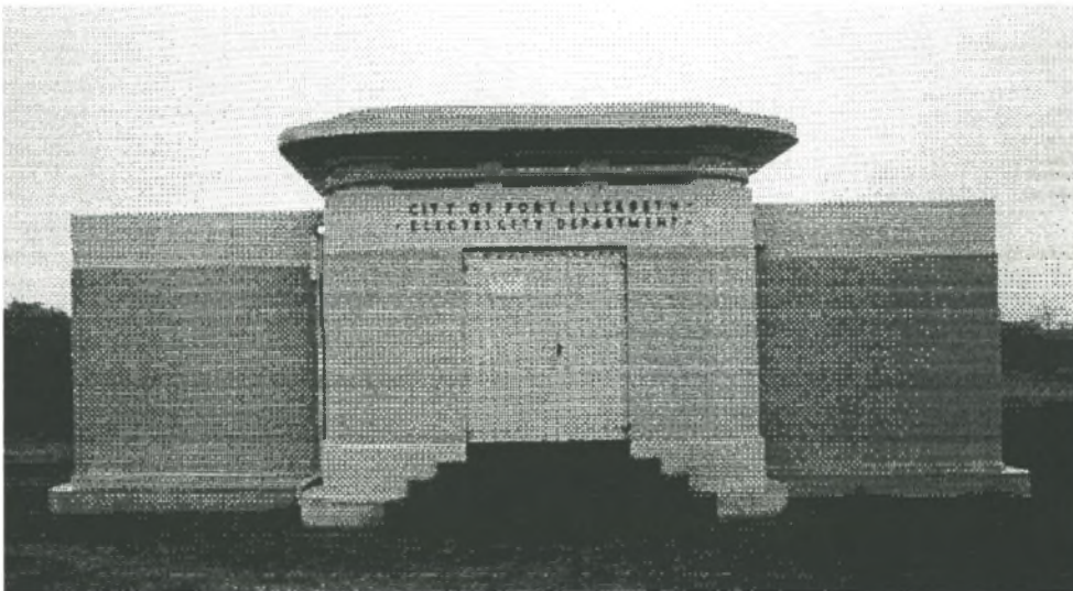
Figuur 10.8 Elektriese substasie, Port Elizabeth (Van der Linde 1999:fotoreeks)
