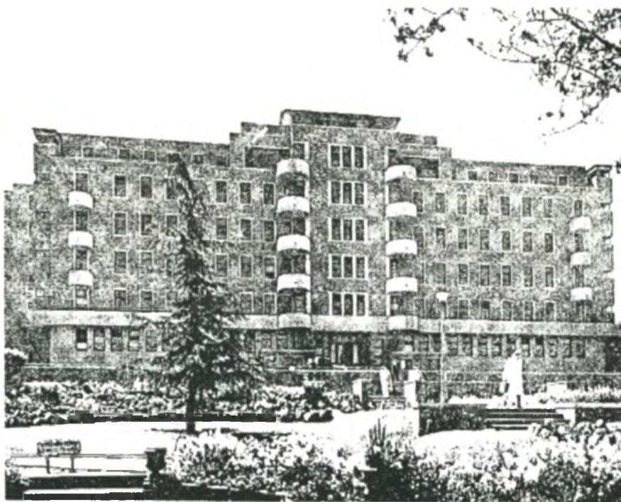
Figuur 3.8 Johannesburg Algemene Hospitaal – hoofblok (SAB Oktober 1939)
