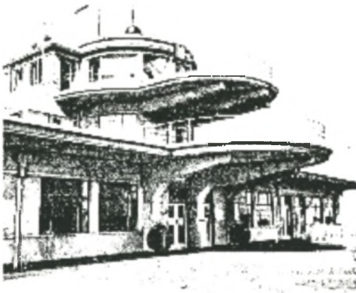
Figuur 3.11a Randlughawe-fasade ( SA Builder Desember 1935)
