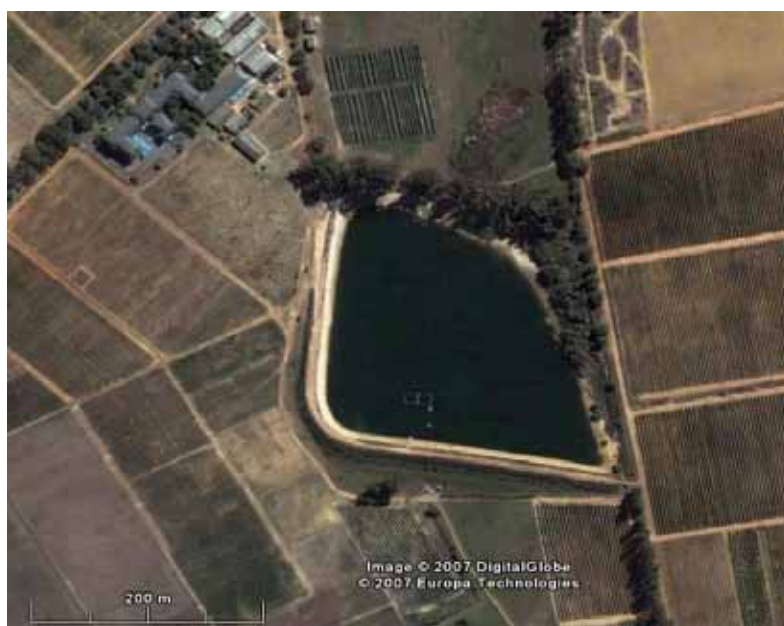
Figure 2.1: Aerial view of Nietvoorbij Dam at Nietvoorbij research Station (Production site 1)
