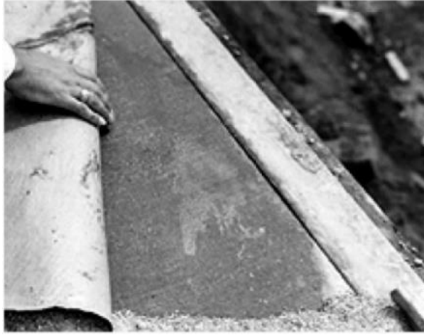
Figuur 2.10: Ondeurdringbare papierkuring (Cement concrete & aggregeate Australia, 2006)
