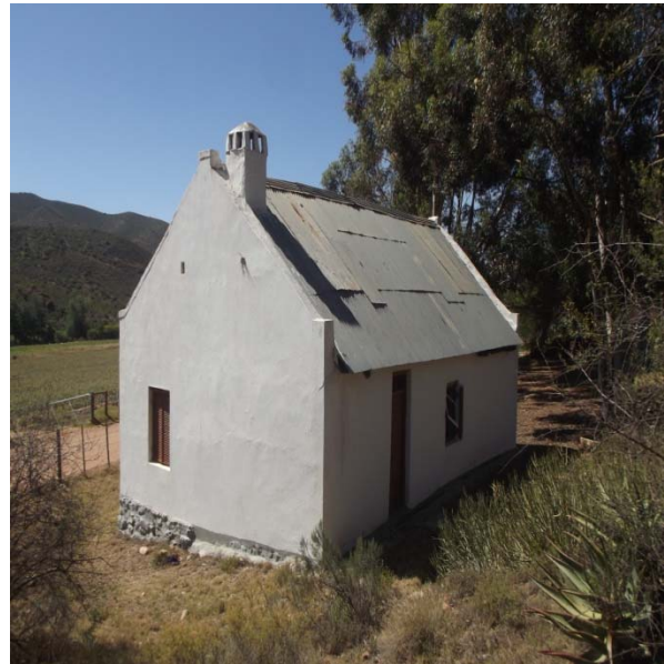
Figuur 15: Onderwyserswoning te Vergelegen (1913) (Foto: O Stander)
