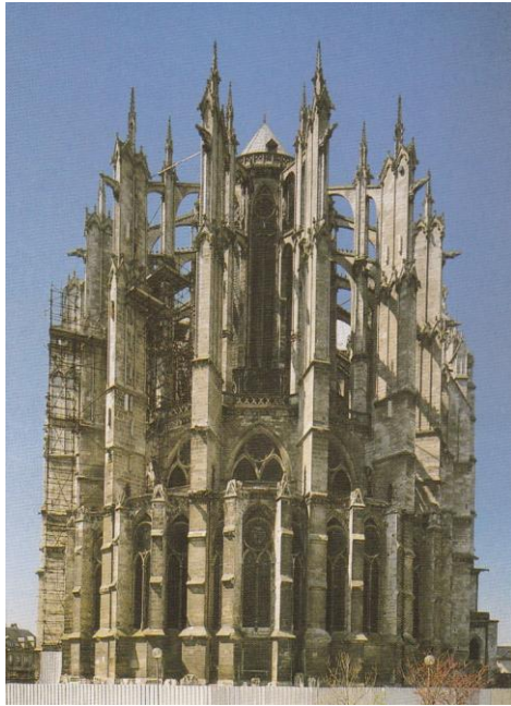
Figuur 7: Die katedraal van St Pierre, Bauvais (Klein 2007:66)
