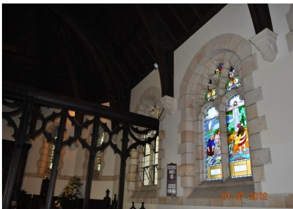
Figuur 45: Doringkroon-skerm van stinkhout, Neo-Gotiese dakbalke gestut op uitgebreide consoles en 'n voorbeeld van die gekleurde glasventers
