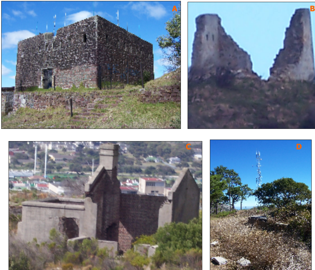
Figuur 7: A: King's-blokhuis; B: Queen's-blokhuis; C: Prince of Wales'-blokhuis; D: Seinstasie-fondament.
