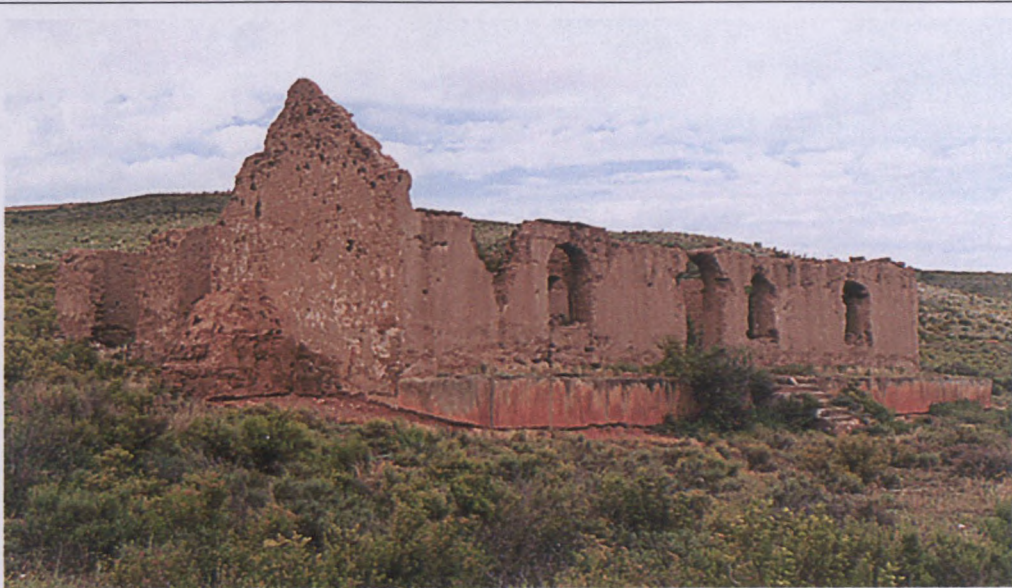
Figuur 51: Vensterkonstruksie Melkhoutbos (VB EB 1992)
