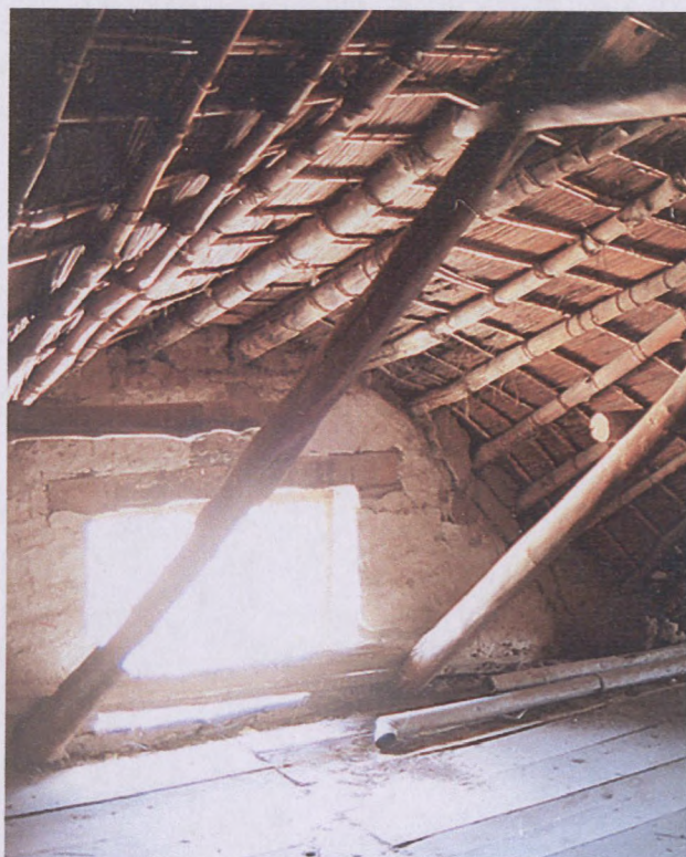
Figuur 73: Wolfneusgewelkonstruksie in die buitegebou van die Barry en Neefs Winkel, Malgas (VB EB 1991)
