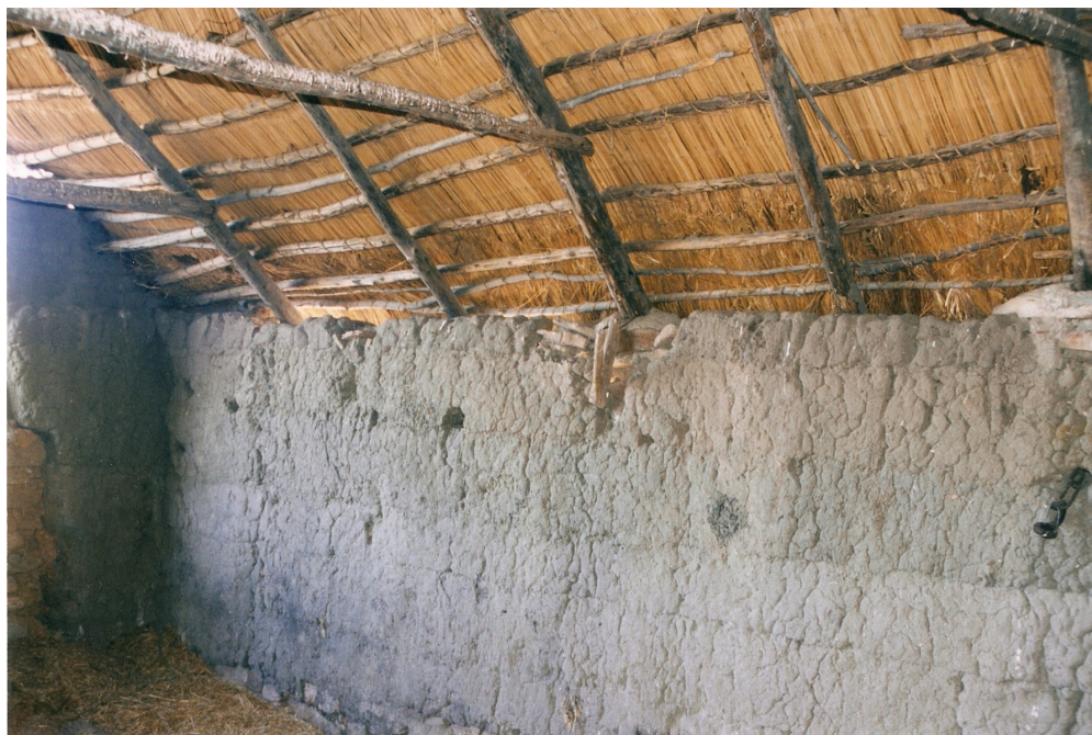
Figuur 27: Dakkonstruksie van stal (Foto: M Visser 2003)
